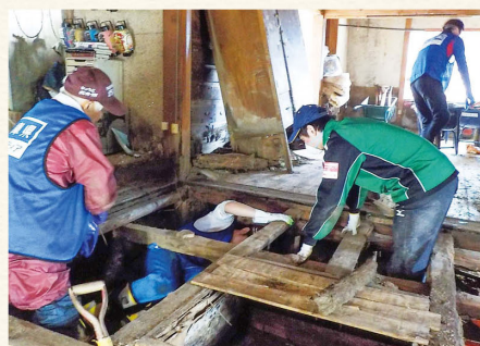
家屋からの泥出し作業を行う組合員や職員 (2017年 九州北部豪雨)
