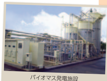
バイオマス発電施設
