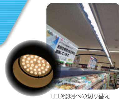
LED照明への切り替え
