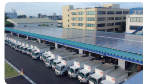
2017年10月に新設したスマートKC(協同購入センター伊丹)
