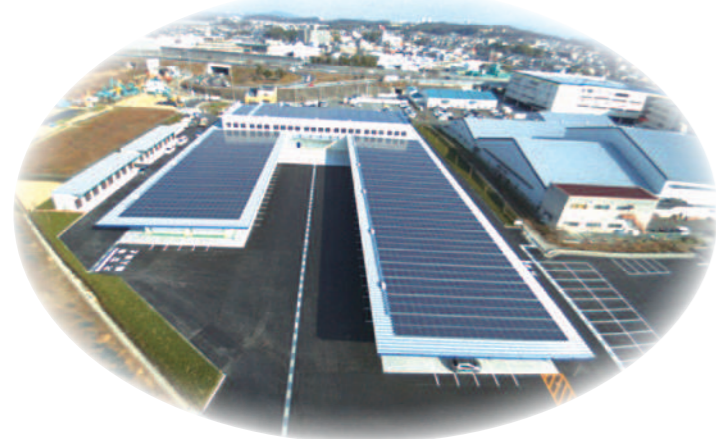
西神戸発電所(協同購入センター西神戸)
