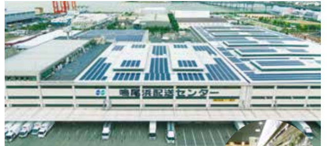
上：コープこうべ鳴尾浜配送センター 屋上の太陽光パネル
